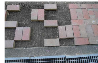
インターロッキング
